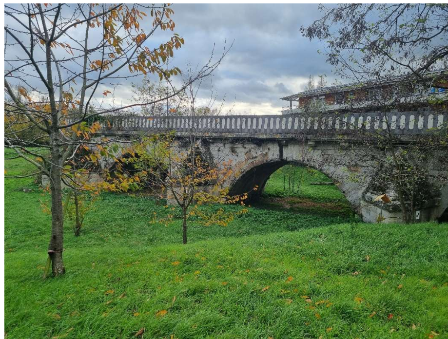
Figure 6 Vue de l'ancien pont coté Carrières-sous-Poissy sur lequel s'appuiera la nouvelle passerelle
