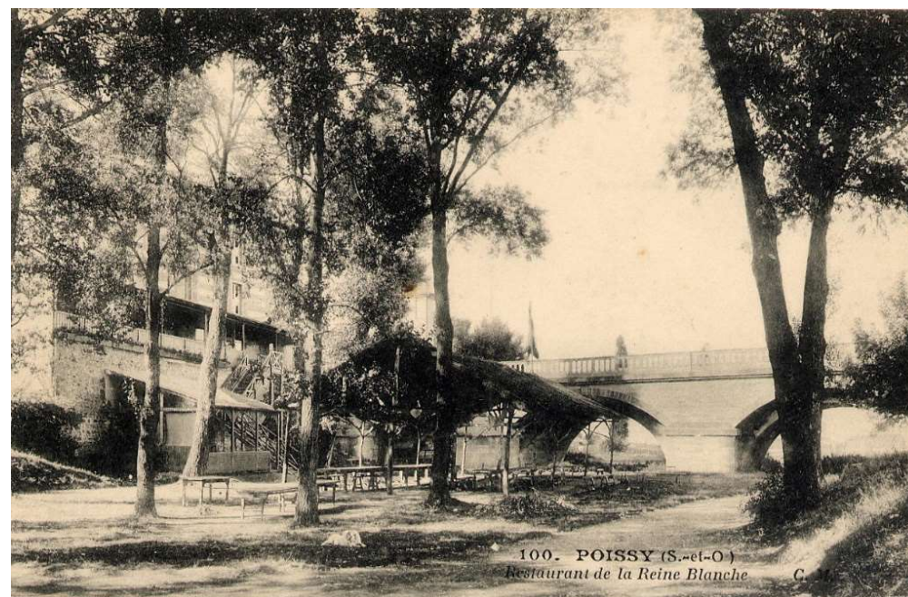
Figure 21 Le pont coté Carrières-sous-Poissy On voit que l'anse a été comblée
