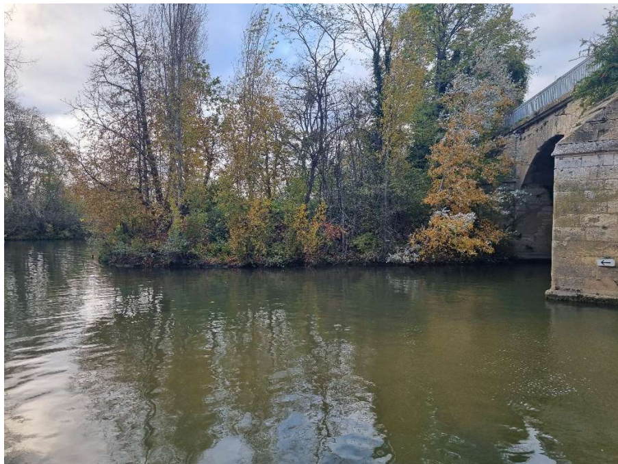
Figure 7 Vue de l'ancien pont coté Poissy. On remarque l'îlot sur lequel était prévu une placette, mais qui sera finalement conservé en l'état.
