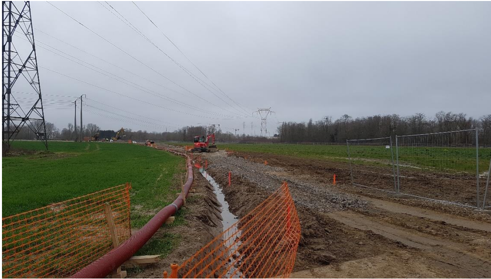
Figure 4 vue du site depuis le nord est
