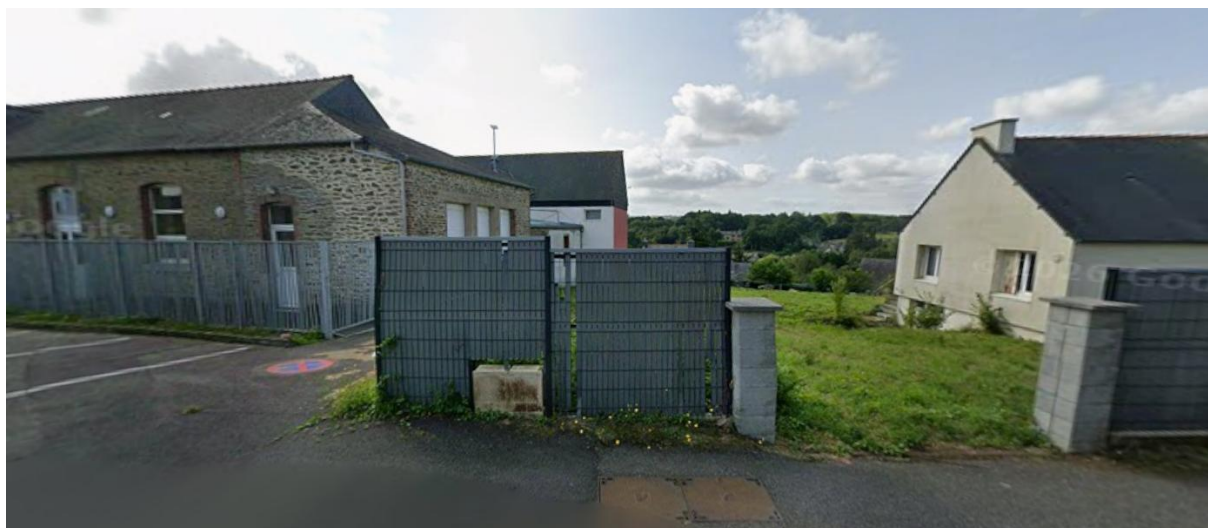
Figure 2 - Vue issue de Google Street View depuis l'entrée de l'école Saint-Pierre
