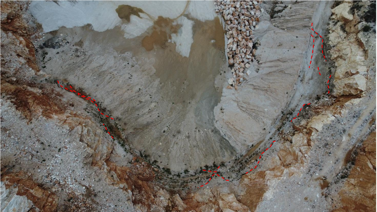
Figure 26 : illustration et localisation des désordres observés au niveau du talus en extrémité Est de l'exploitation
