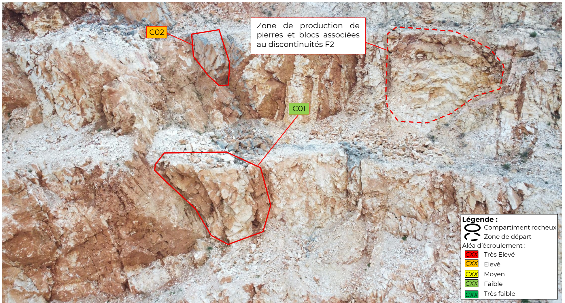
Figure 20: localisation sur photo aériennes des instabilités ponctuelles observée et niveau d'aléa d'éroulement associés, niveau 198 et 217 fronts Est.
